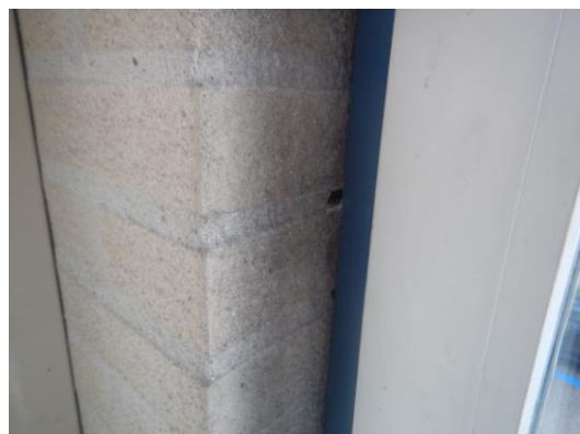
Aansluiting kozijn en metselwerk
