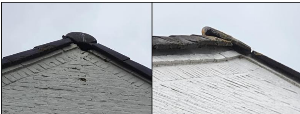
Figuur 1.3 Middels kierende kantpannen en open stootvoegen kunnen gierzwaluwen en vleermuizen toegang krijgen tot binnenruimtes waardoor potentie voor vorengenoemde soorten niet uitgesloten kan worden.
