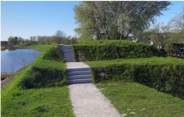
Betontrappen (standaardoplossing stelling van Amsterdam)
