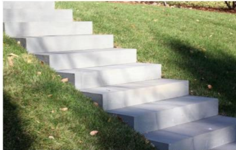
Betontrappen (standaardoplossing stelling van Amsterdam)
